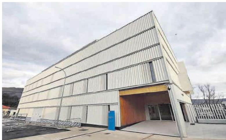
Estado actual del nuevo centro de salud en los terrenos de Sisalde. | Santos Álvarez
